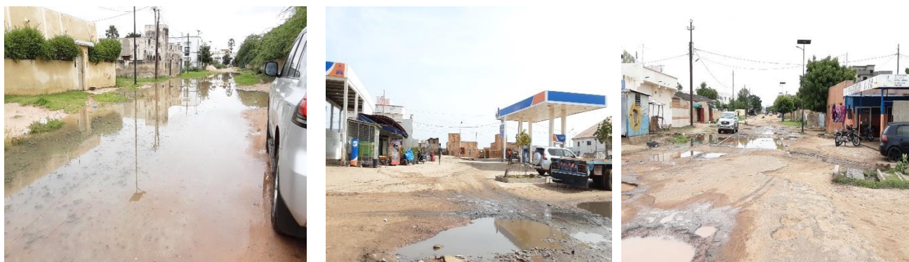
Photos de quelques points bas sur les axes Thioffack-Cimetière Médina Baye et Sortie Ndangane - N1 - route de MB, qui sont envahies par les eaux pluviales
