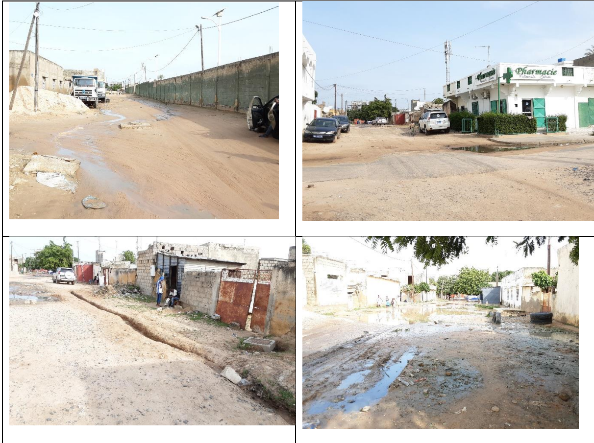
Photo 3 : Vue de la zone restreinte de l'axe
