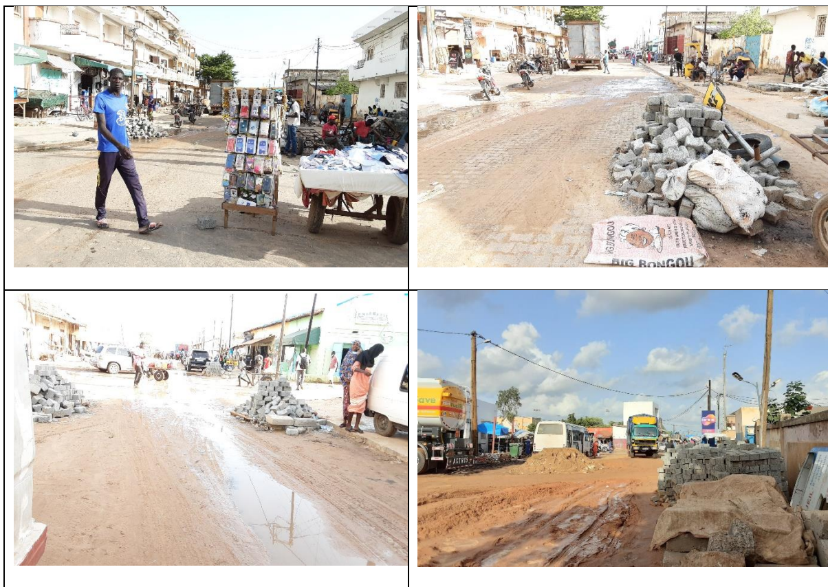
Photo 4 : Vue de la zone restreinte de l'axe
