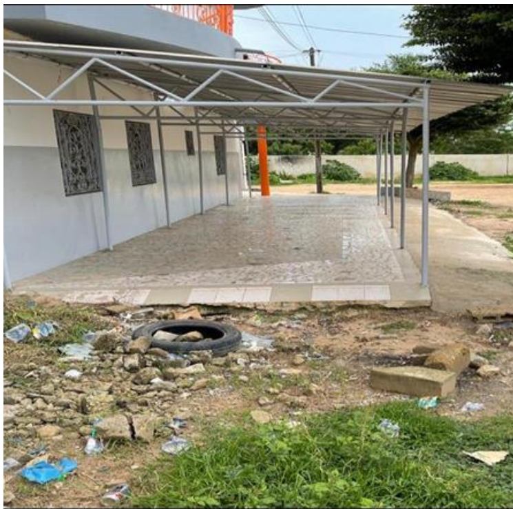
Figure 3 : Vue de la structure connexe impactée H0006
