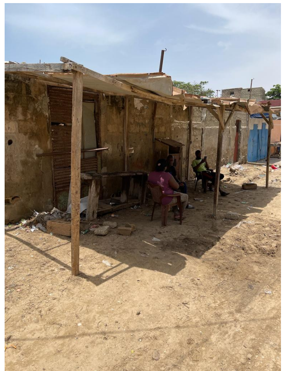
Menuiserie bois impacté dans le quartier Tendjiguen
