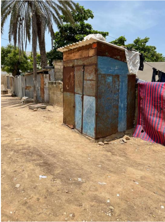
Boutique (kiosque) impacté dans le quartier Tendjiguen
