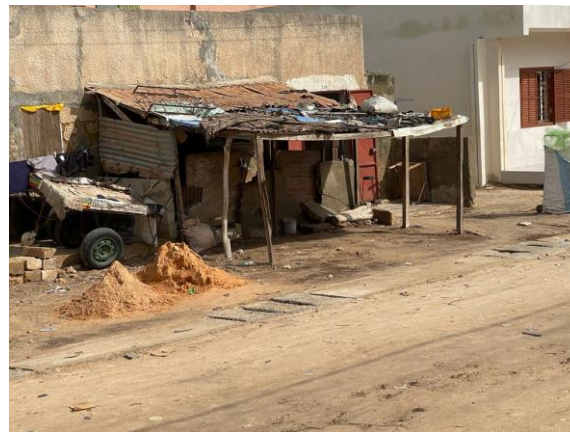
Menuiserie métallique impacté dans le quartier Diameguène
